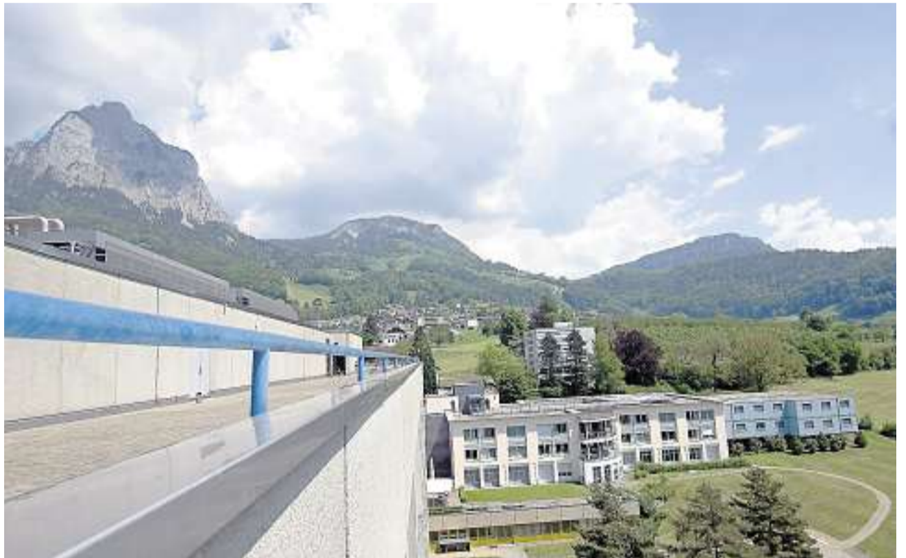
Provisorium bleibt dauerhaft stehen: Das «blaue» Bettenhaus wurde als provisorische Bettenstation für die Bauzeit gekauft. Das Gebäude soll künftig zu Büroräumlichkeiten umfunktioniert werden. Bild Andreas Seeholzer
